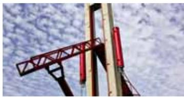
Ein Projekt der TU Wien. Die Klappbrücke wird ausschließlich über eine Wasserpumpe bewegt.
